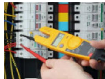
Técnico de Instalações Elétricas
